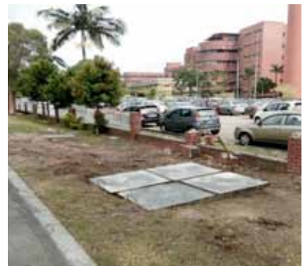
x. Mengganti Grating/Konkrit Penutup Parit Dan Takung (Ganti Penutup Longkang Yang Rosak)
