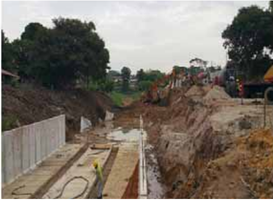
viii. Kerja Kerja Membaiki Penutup Parit Utama Di Dataran Bandaraya Majlis Bandaraya Johor Bahru
