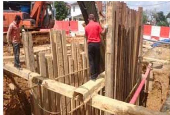
x. Kerja-Kerja Membina Tembok Kolam di Loji Rawatan Kumbahan Jalan Harmoni 4/12, Taman Desa Harmoni, Johor Bahru
