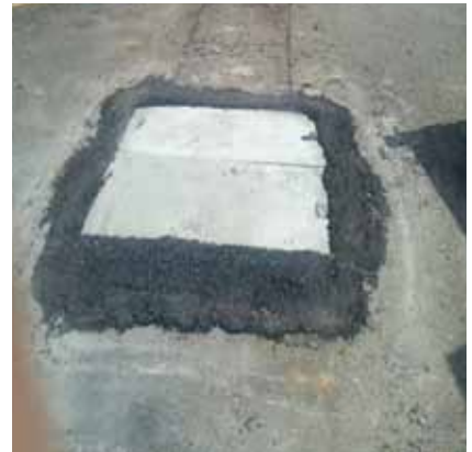
x. Mengganti Grating/Konkrit Penutup Parit Dan Takung (Ganti Penutup Longkang Yang Rosak)
