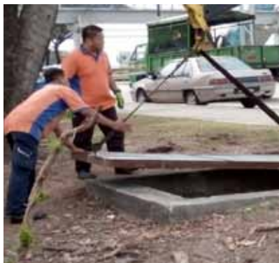
x. Mengganti Grating/Konkrit Penutup Parit Dan Takung (Ganti Penutup Longkang Yang Rosak)
