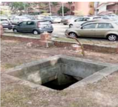
x. Mengganti Grating/Konkrit Penutup Parit Dan Takung (Ganti Penutup Longkang Yang Rosak)
