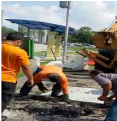
x. Mengganti Grating/Konkrit Penutup Parit Dan Takung (Ganti Penutup Longkang Yang Rosak)
