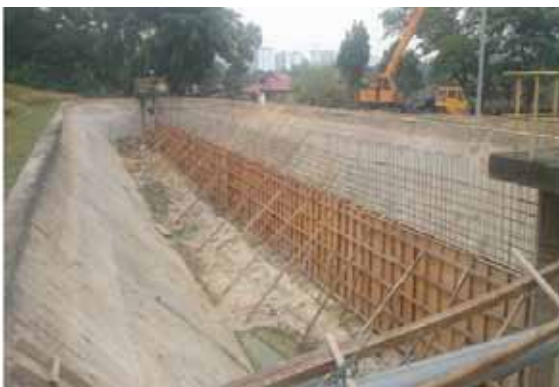
x. Kerja-Kerja Membina Tembok Kolam di Loji Rawatan Kumbahan Jalan Harmoni 4/12, Taman Desa Harmoni, Johor Bahru
