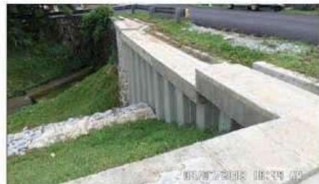
Kerja membaiki struktur tebing sungai yang runtuh di Jalan Pantii dan kerja menaiktaraf parit tanah kepada parit konkrit dan melalui sistem perparitan bertingkat di Jalan Pantii 1, Taman Johor.
