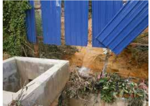
Gambar 6.1 : 'Sediment fence' telah rosak dan rumput tidak ditanam pada cerun', Lokasi Jalan Kempas 9/6, Kempas
