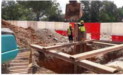
Gambar 3.14: Kerja Mengganti Paip Kumbahan (Dalam 5 meter) Di Jalan Mutiara Emas 5/20, Taman Mount Austin
