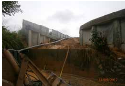
Gambar 6.4 : Tembok penahan runtuh. Lokasi Di Jalan Ketam, Taman Suria.
