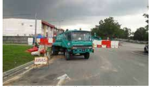
Gambar 3.14: Kerja Mengganti Paip Kumbahan (Dalam 5 meter) Di Jalan Mutiara Emas 5/20, Taman Mount Austin
