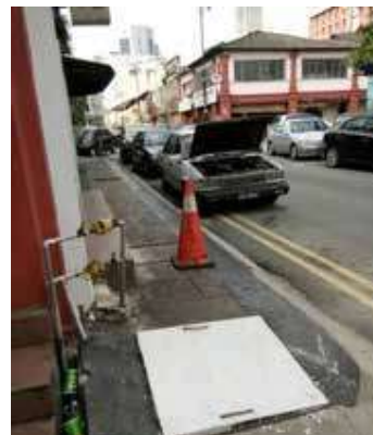
Gambar 5.4 : Kerja Menggantikan Penutup Parit Rosak/Hilang
