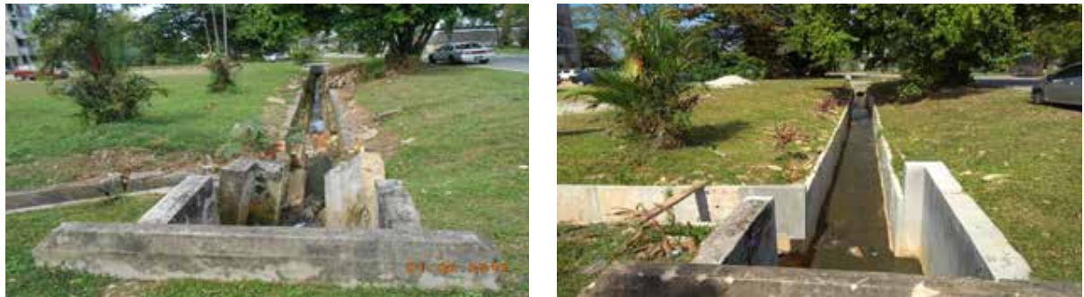
Gambar 3.2: Kerja menaiktaraf parit di Perumahan Jalan Bertam 1, Taman Daya bagi menangani masalah banjir.
