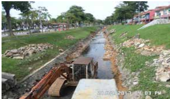
Gambar 3.9: Kerja menaiktaraf tebing saliran di Jalan Padi Emas 1, Bandar Baru Uda.
