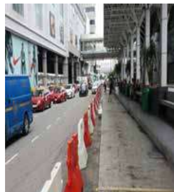
Gambar 5.5 : Kerja Menutup Jalan Menggunakan "Barrier"
