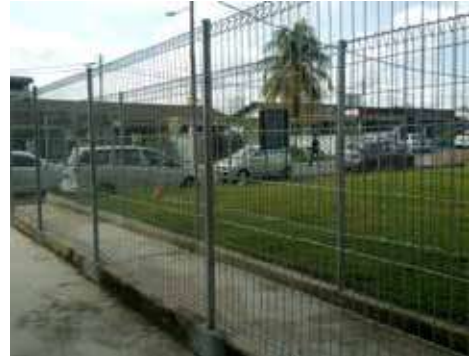
Memasang Pagar 'Anti Climb' Jln Rusa Tmn Abad
