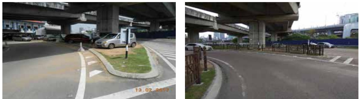
Gambar 3.3: Kerja Pemasangan Pagar Penghadang di Jalan Sawmill / Jalan Tun Abdul Razak.
