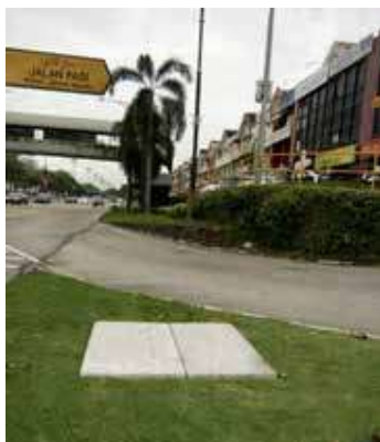
Gambar 5.4 : Kerja Menggantikan Penutup Parit Rosak/Hilang
