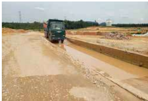
Gambar 6.3 : Jalan Harmonium kotor dan 'wash through' tidak diselenggara dgn baik di tapak, Lokasi di Jalan Harmonium, Taman Desa Tebrau.
