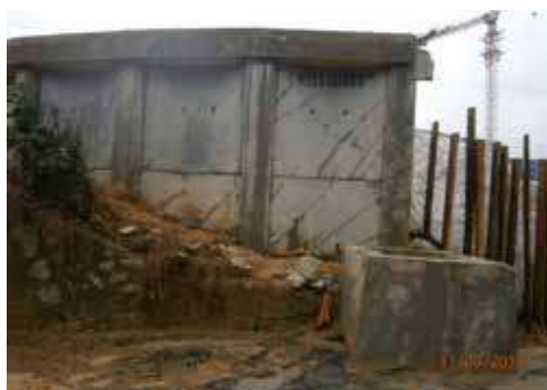
Gambar 6.4 : Tembok penahan runtuh. Lokasi Di Jalan Ketam, Taman Suria.
