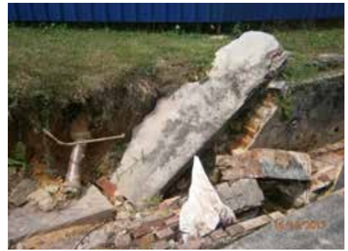
Gambar 6.5 : Tiada 'silt fence' 'sediment basin tidak diselenggara, tembok dan parit tepi jalan runtuh, Lokasi di Jalan Rebung, Kg. Bendahara.
