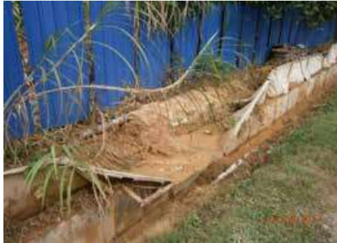
Gambar 6.1 : 'Sediment fence' telah rosak dan rumput tidak ditanam pada cerun', Lokasi Jalan Kempas 9/6, Kempas
