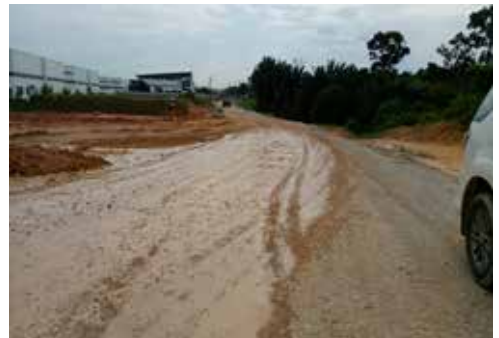
Gambar 6.3 : Jalan Harmonium kotor dan 'wash through' tidak diselenggara dgn baik di tapak, Lokasi di Jalan Harmonium, Taman Desa Tebrau.
