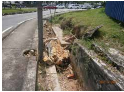
Gambar 6.5 : Tiada 'silt fence' 'sediment basin tidak diselenggara, tembok dan parit tepi jalan runtuh, Lokasi di Jalan Rebung, Kg. Bendahara.
