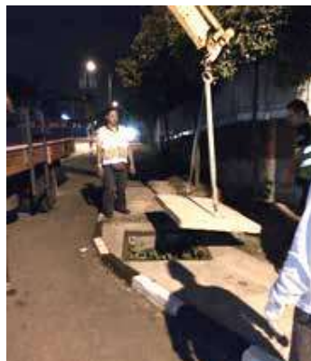
Gambar 5.4 : Kerja Menggantikan Penutup Parit Rosak/Hilang
