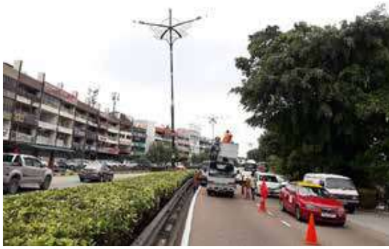
Gambar 3.20 : Kerja Penggantian Lampu Jalan LED di Jalan Tebrau, Jalan Skudai dan Jalan Tun Abdul Razak serta Ujian Pencahayaann (Lux Measurement) bagi memastikan cahaya mengikut spesifikasi ditetapkan.
