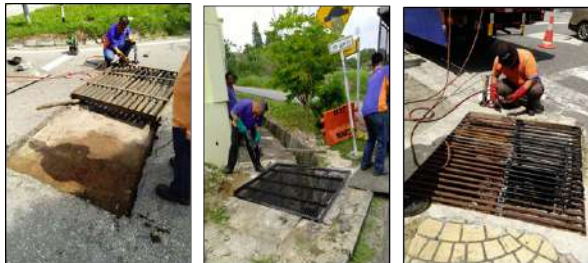
Gambar 2.49: Kerja Menggantikan Penutup Parit Rosak/Hilang
