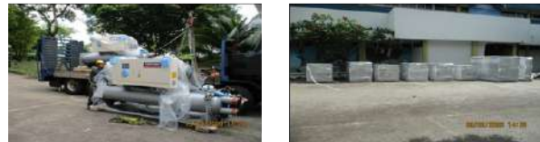
Gambar 2.38: Kerja Menaiktaraf Sistem Chiller Hawa Dingin Perpustakaan Sultan Ismail.
