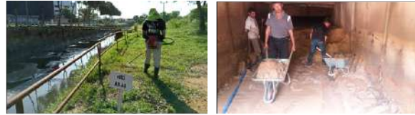
Gambar 2.21: Kerja Kerja Penyelenggaraan Pembersihan Sungai Dan Parit Utama.
