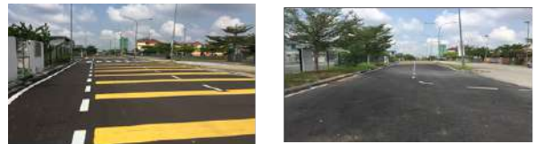
Gambar 4.2 : Pemantauan Kerja Penurapan Semula Jalan Selepas Kerja Korekan Bagi Pemasangan Paip Dan Kabel, Di Jalan Harmoni Utama.
