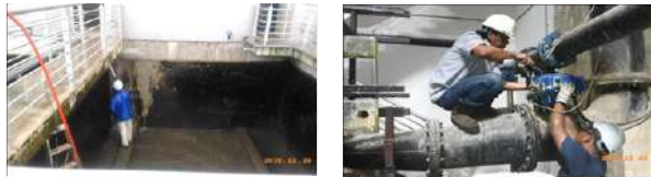
Gambar 2.24: Kerja Kerja Penyelenggaraan Loji Rawatan Kumbahan CSTP Segget, Johor Bahru.
