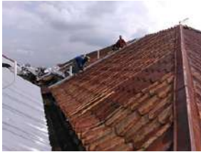
Menggantikan bumbung Blok Pangsapuri Pahlawan C
