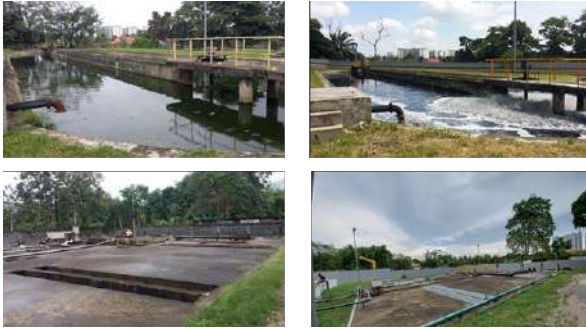
Gambar 2.26: Kerja Kerja Menaiktaraf Logi Rawatan kumbahan Taman Kemas & Taman Desa Harmoni.
