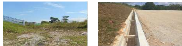
Gambar 2.7: Kerja-Kerja Pembinaan Tempat Letak Kereta di Atas Rizab Jalan Bersebelahan Masjid Taman Megah Ria, Jalan Kempas, Taman Megah Ria Johor Bahru.
