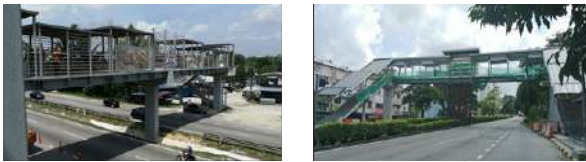
Gambar 2.36: Kerja-Kerja Membina Jejantas Di Lebuhraya Pasir Gudang, Kempas, dan Jalan Tun Abdul Razak Menghubungkan Jalan Susur 3 & Jalan Susur 4, Johor Bahru.
