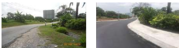
Gambar 4.9 : Membina Laluan Pejalan Kaki Dan Menaiktaraf Jalan Bagi Menghubungkan Ke Jalan Harmonium 24, Taman Mount Austin, MB Johor Bahru.
