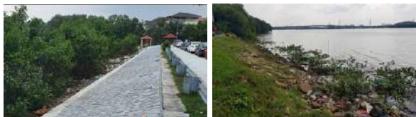
Gambar 2.20: Kerja Kerja Pembaikan Tembok Sg Seranggong Serta Kerja Kerja Berkaitan Di Taman Sri Intan, Johor Bahru.
