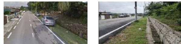
Gambar 2.9: Kerja-Kerja Menurap Kawasan Lapang Anjung Selera Cempaka, Johor Bahru.
