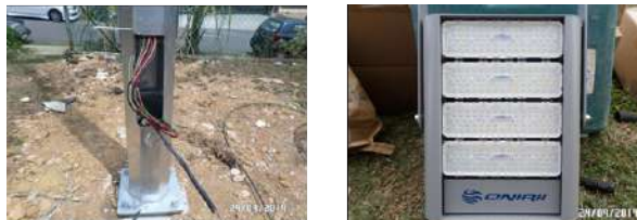
Gambar 3.12 : Kerja-Kerja Pencahayaan Di Jalan Anggerik 32, Taman Johor Jaya, Johor Bahru, Di Bawah Program Bandar Selamat ( Peruntukan Persekutuan).
