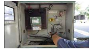
Gambar 2.45: Kerja Penyelenggaraan Lampu Taman.
