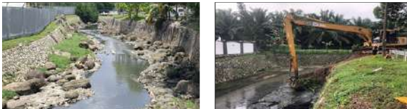
Gambar 2.19: Kerja Kerja menggali mendakan di Sg Sengkuang, Johor Bahru.
