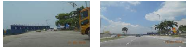
Gambar 2.6: Kerja-Kerja Mengecat Garisan Jalan Dalam Rizab Jalan JKR di Kawasan Pusat Bandar Johor Bahru.
