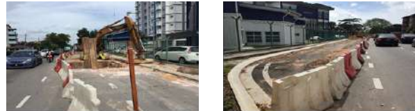
Gambar 4.1 : Pemantauan Kerja Korekan Bagi Pemasangan Paip Pembetulan, Di Jalan Langkasuka, Larkin.
