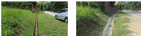
Gambar 4.10 : Kerja-Kerja Menaiktaraf Longkang Di Jalan Straits View, MB Johor Bahru.
