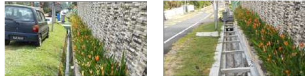
Gambar 2.5: Kerja-Kerja Menaiktaraf Sistem Perparitan dan Kerja Berkaitan di Jalan Rajawali Larkin Johor Bahru.
