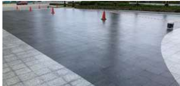
Pembersihan Lantai Laman Mahkota, Mengecat Pintu Pagar Dan Kerja Berkaitan
