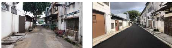
Gambar 4.11 : Menaiktaraf Lorong Belakang Di Jalan Permatang 8, Taman Desa Jaya, MB Johor Bahru.
