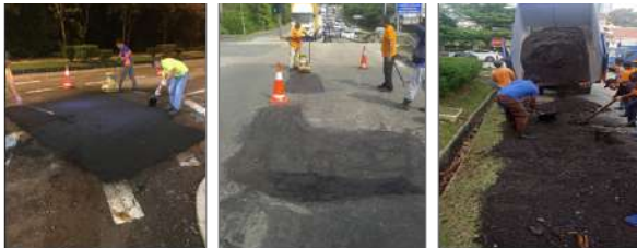
Gambar 2.48: Kerja Menampal Jalan.
