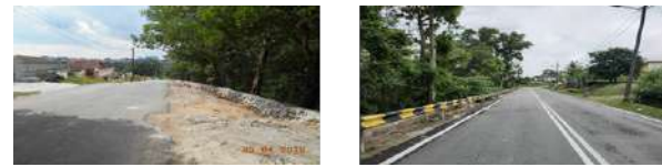
Gambar 2.8: Kerja-Kerja Membina Parit dan Jalan Di Jalan Susur 1, Banjaran 10 Kempas Johor Bahru.
