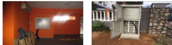
Gambar 2.39: Kerja Menaiktaraf Bekalan TNB Di Dewan Kg Melayu.
