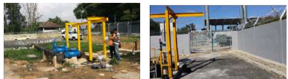
Gambar 2.25: Kerja Kerja Menaiktaraf Loji Rawatan kumbahan Jalan Sagu 7, Taman Daya & Stadium Hoki Taman Daya. Berkaitan Di Taman Sri Intan, Johor Bahru.
