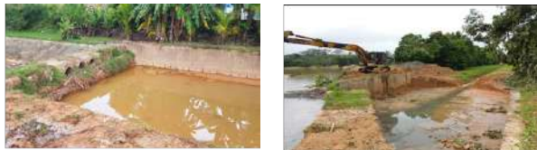
Gambar 2.23: Kerja Kerja Menggali Mendakan Bagi Mengatasi Masalah Banjir Di Jalan Setia Indah 12/1, Taman Setia Indah, Johor Bahru.
