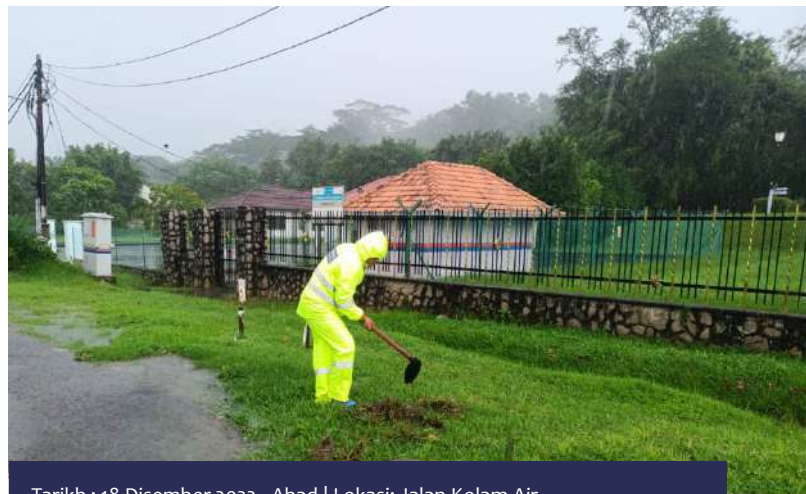
Tarikh : 18 Disember 2022 - Ahad | Lokasi : Jalan Kolam Air Air bertakung di atas jalan bersebelahan Pintu Masuk Istana Bukit Serene. Skuad Kilat bertindak membersihkan rumput yang menutup aliran air.
