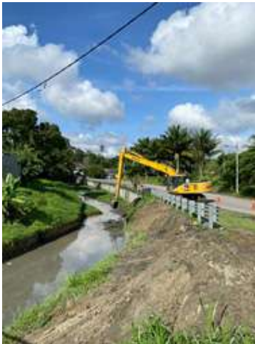
Kerja-Kerja Penyelenggaraan Perangkap Sampah Jenis GPT, Lokasi Serta Kerja Pembersihan dan Penggalian Sungai di sekitar Kawasan MBBJ
